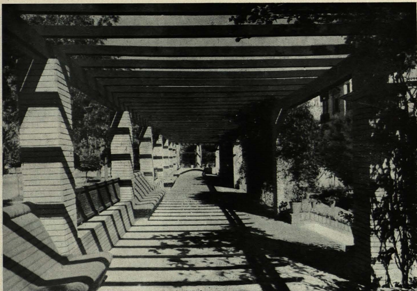
Detalle de la pérgola construída en el jardín.
